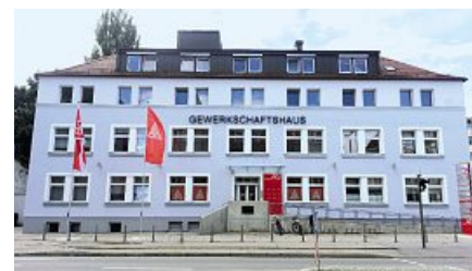
Das neue Gewerkschaftshaus in der Landshuter Nikolastraße
