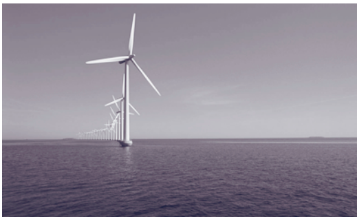
Foto: AN Windenergie
