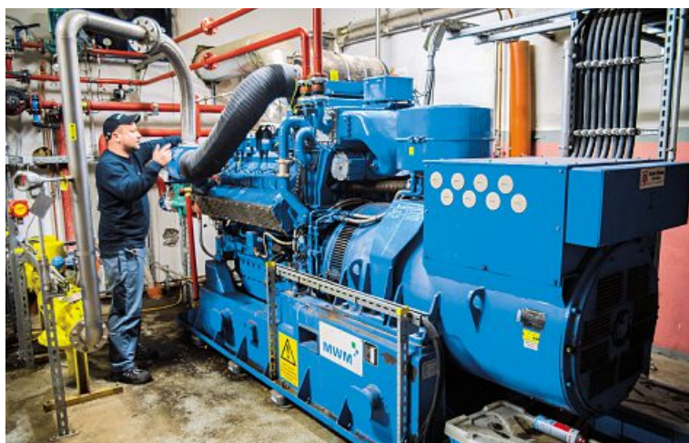
Zukunftskonzept entwickelt: Alle Blockheizkraftwerke sind Einzelstücke.
