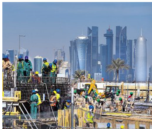
Auf den Baustellen für die Fußball-WM in Katar herrschen sklavenähnliche Bedingungen für die Arbeiter.
